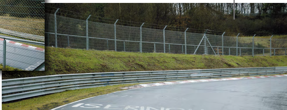
In der „Grünen Hölle“ wurden FIA-Sicherheitszäune installiert.
